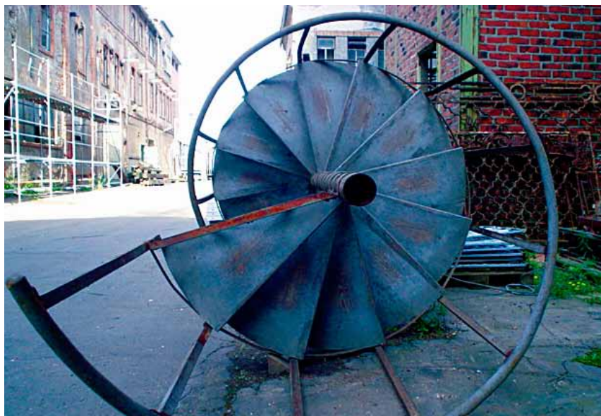
Bei Abbruch- oder Umbauarbeiten lassen sich oftmals nach wie vor funktionsfähige Bauteile finden, auf die neue Einsatzorte warten. Hier: eine Treppe.
