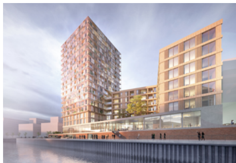
In der Hamburger HafenCity entsteht das höchste Holzhochhaus Deutschlands. Die Konstruktion ist aus nachhaltig zertifiziertem Holz.
